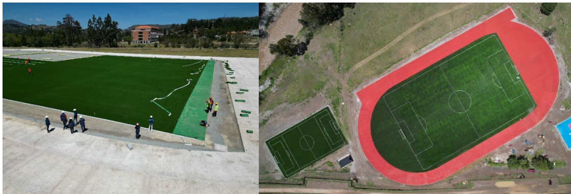
Construcción de cancha de fútbol 11
