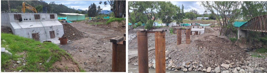
Construcción de obra falsa y estribos
