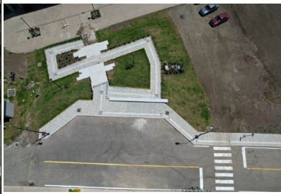
Construcción de Acceso bloque B
