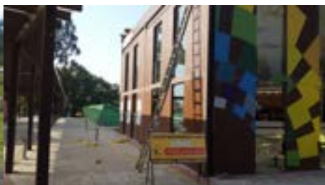
Reparaciones en la Biblioteca
