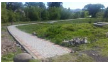
Construcción de caminería
